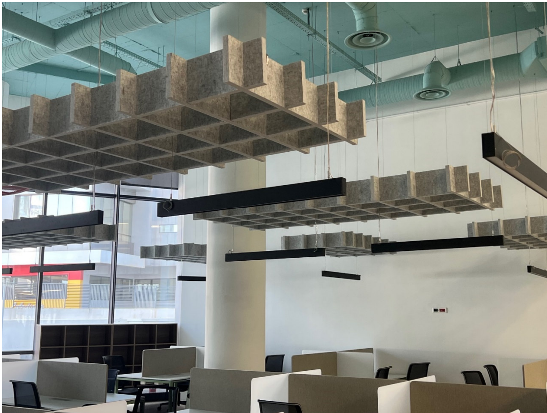
Acondicionamiento de oficinas (Fotecma)
