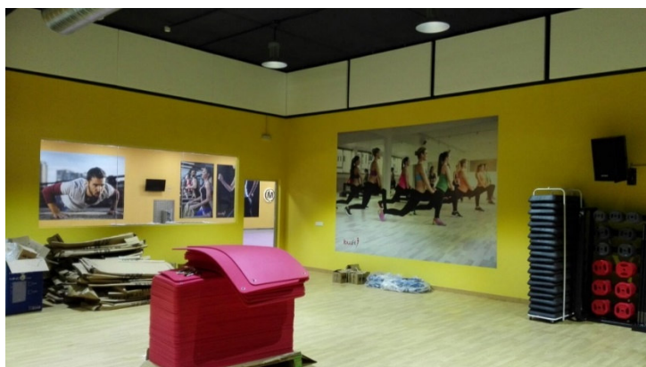
Instalación Croxon Baflox (15 x 1000 x 2000 mm) en gimnasio Sevilla.
