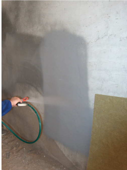
Formación de membrana acústica in situ para pegado de lana mineral.
